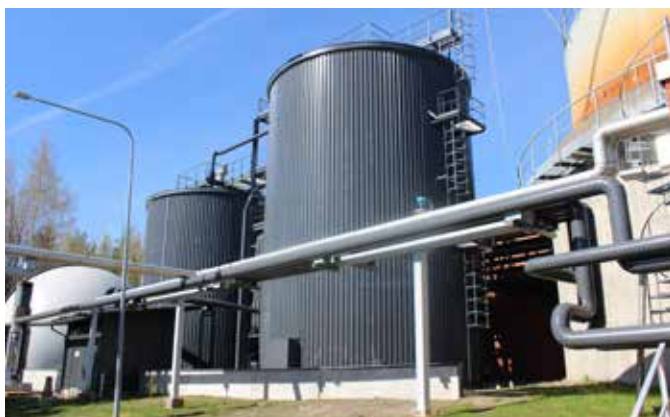
Raakalietesäiliö ja tiivistetyn lietteen säiliö
