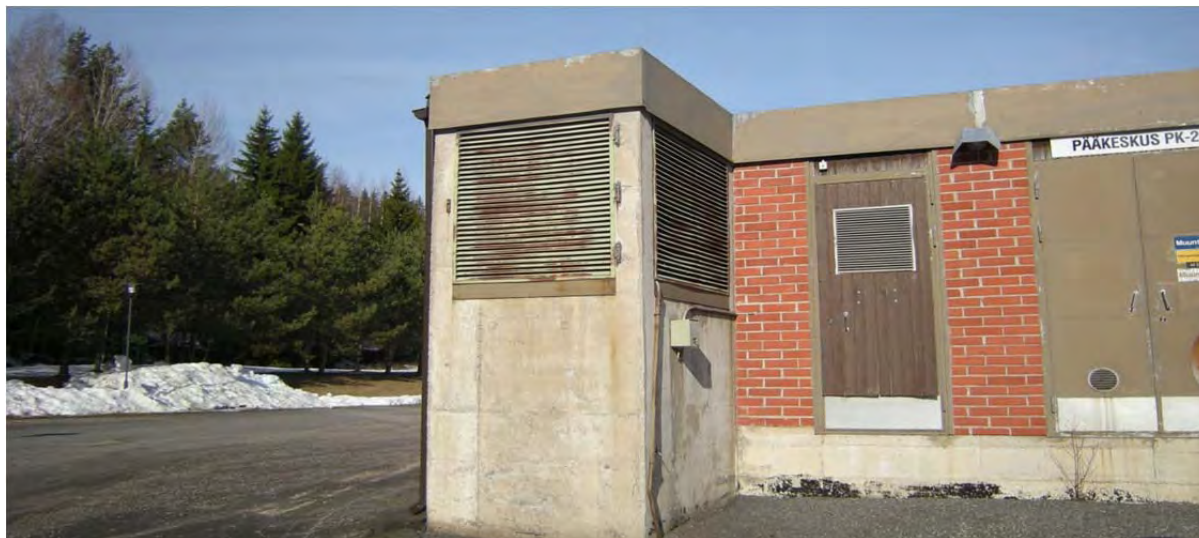
Kuva 4.3.1. Äänilähde 6 (kompessoriaseman betoninen ilmanotto), ääni on kapeakaistaista 100 Hz ja 160 Hz taajuuksilta.
